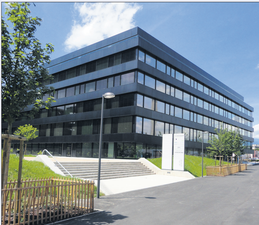
► Le nouveau siège Gerofinance-Dunand | Régie de la Couronne à Vernier.
